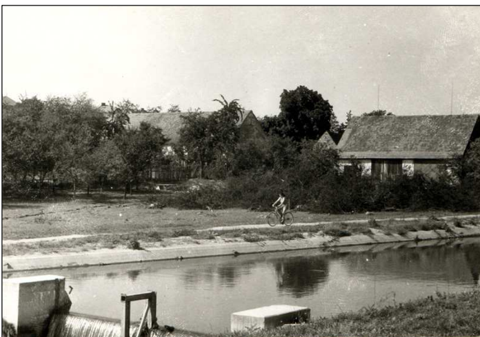
Požární nádrž v Trnové vybudovaná v korytě bělského potoka 17. října 1974.
